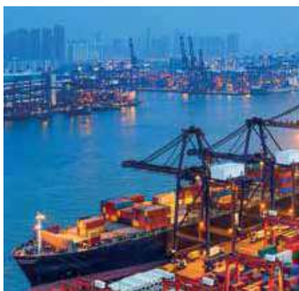
Cantiere navale - Terminal container
