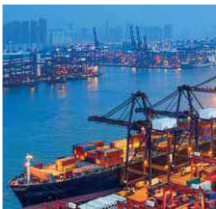
Cantiere navale - Terminal container
