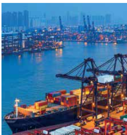
Cantiere navale - Terminal container
